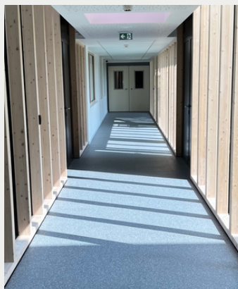
Nouvelle galerie de liaison entre le Centre Hospitalier de Haguenau et AURAL
